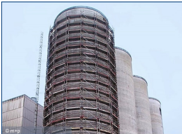
nachträgliche Vorspannung Stahlbetonsilo, Holcim, Lägerdorf
