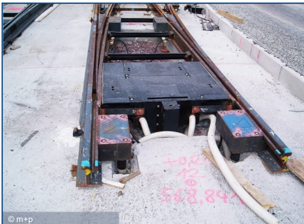
Trogplatte mit Aussparungen, Masse-Feder-System, Magdeburg
