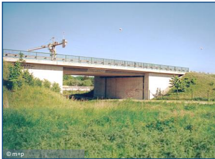
Brückenbauwerk HE 2, Helmstedt
