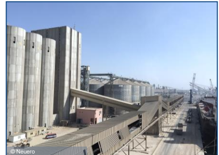
Siloanlage, Damiette, Ägypten
