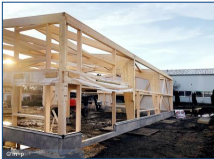
Feuerwehrgerätehaus, St. Andreasberg
