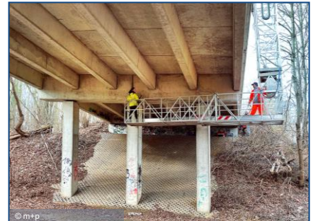
Teufelsspringbrücke, Volkswagen AG Werk Salzgitter
