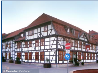
Brandschutzsanierung, Hoffmannhaus, Wolfsburg
