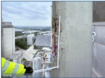
Außenbefahrung, Wärmetauscher Holcim, Werk Höver
