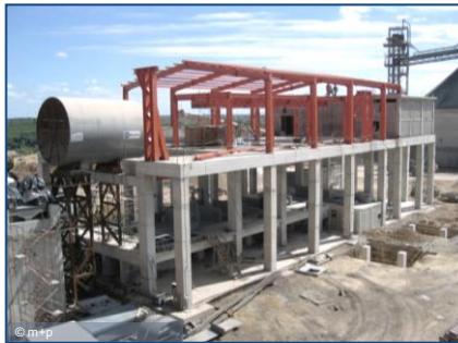
Unterstützungskonstruktion Zementkühler, San Pedro de Macoris, Dominikanische Republik
