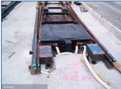
Trogplatte mit Aussparungen, Masse-Feder-System, Magdeburg
