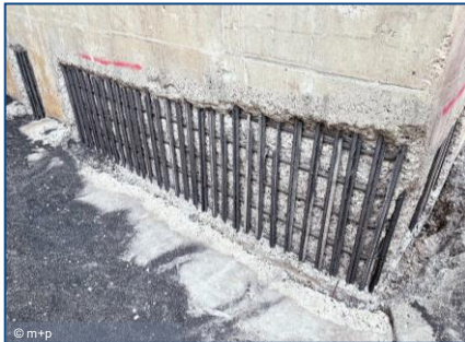
Klinkerförderturm Werk Höver, Holcim, Sehnde
