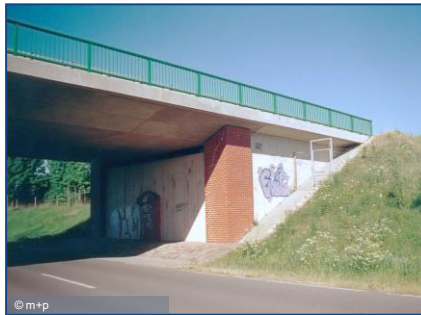
Brückenbauwerk KÄS 3, Kästorf
