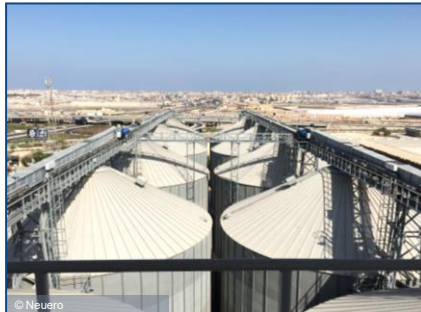
Siloanlage, Damiette, Ägypten
