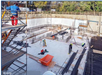
Mehrfamilienhäuser Pelikanviertel, Hannover
