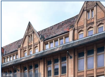
Kaufhaus, Umbau zum Hotel, Stralsund
