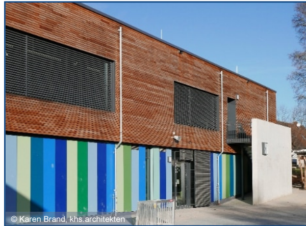
© Karen Brand, khs.architekten Grundschule Wendschott, Wolfsburg
