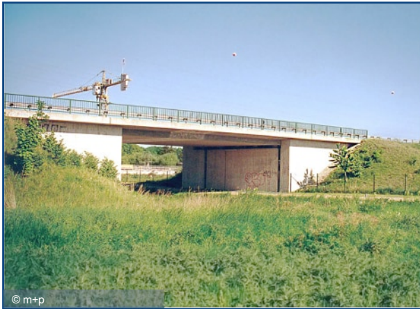
Brückenbauwerk HE 2, Helmstedt
