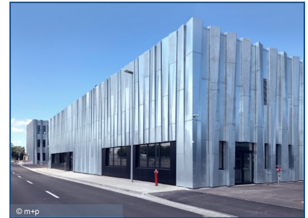
Fassade, Betriebshof WAS, Wolfsburg
