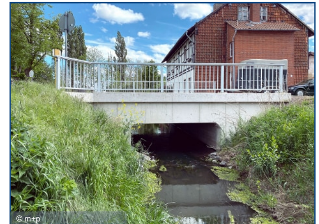
Soltau-Brücke Fabrikstraße, Watenstedt
