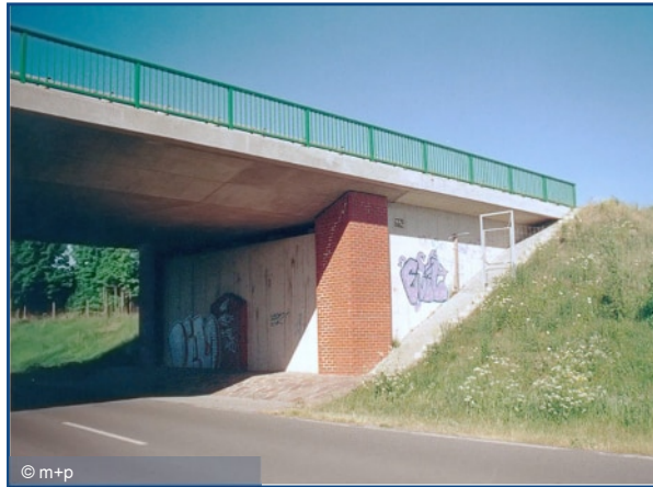
Brückenbauwerk KÄS 3, Kästorf
