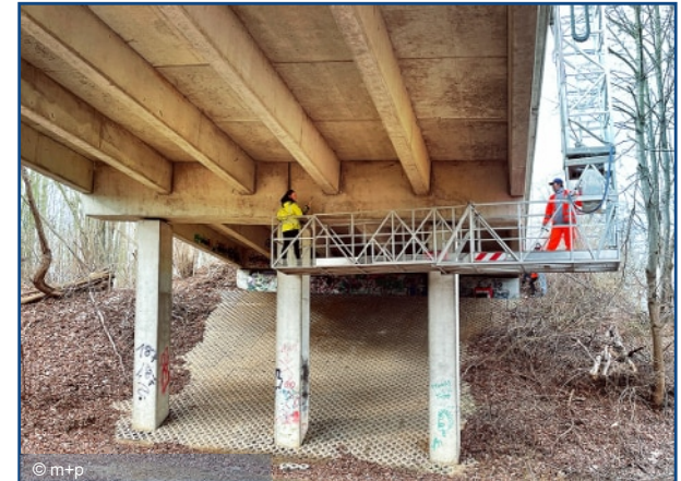
Teufelsspringbrücke, Volkswagen AG Werk Salzgitter
