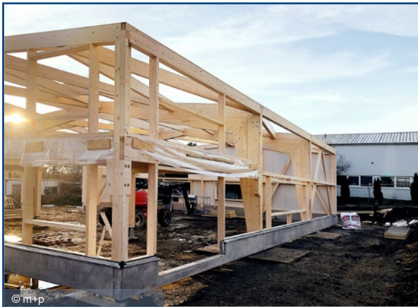
Feuerwehrgerätehaus, St. Andreasberg
