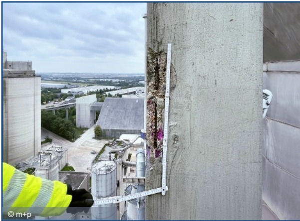
Außenbefahrung, Wärmetauscher Holcim, Werk Höver
