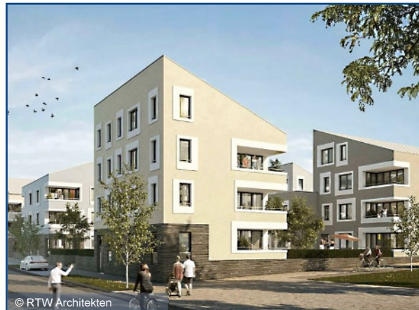
Wohnquartier Hellwinkel, Baufeld E+J, Wolfsburg
