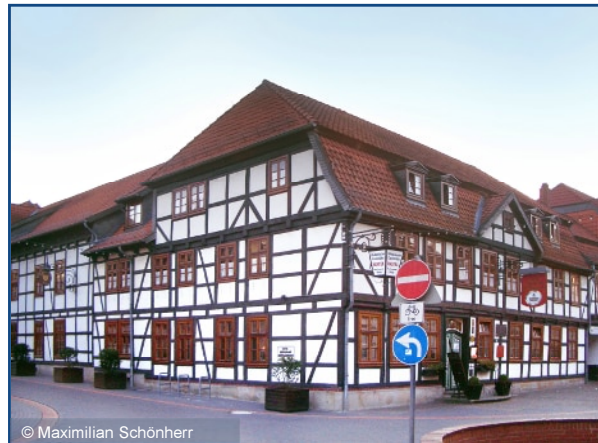
Brandschutzsanierung, Hoffmannhaus, Wolfsburg
