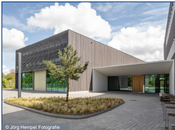
Forschungsgebäude, Zeluba, TU Braunschweig
