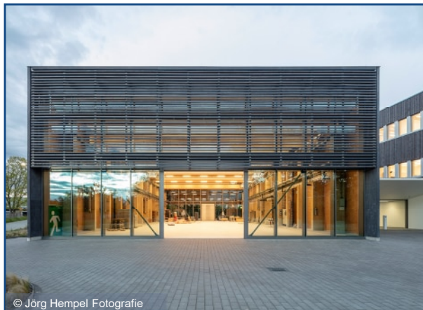
Forschungsgebäude, Zeluba, TU Braunschweig
