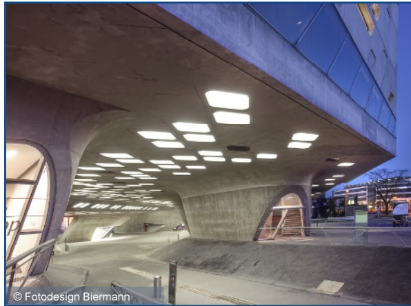
Betoninstandsetzung, Phaeno, Wolfsburg
