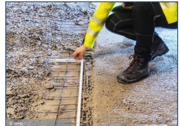
Parkhaus Wilhelmstraße, Braunschweig
