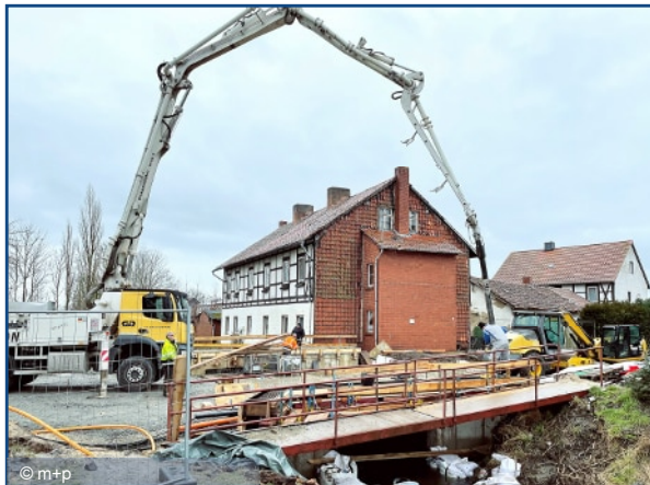
Soltau-Brücke Fabrikstraße, Watenstedt
