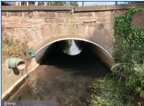
Soltau-Brücke Fabrikstraße, Watenstedt
