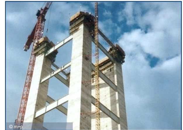
Wärmetauscher, HeidelbergCement, Hannover
