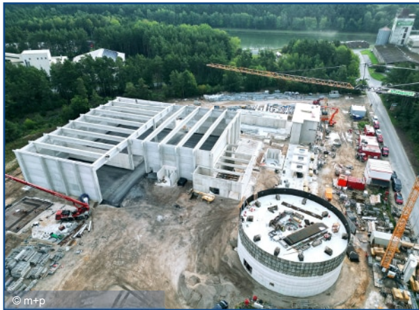
Altholzaufbereitungsanlage, Pfeifer Holz, Uelzen
