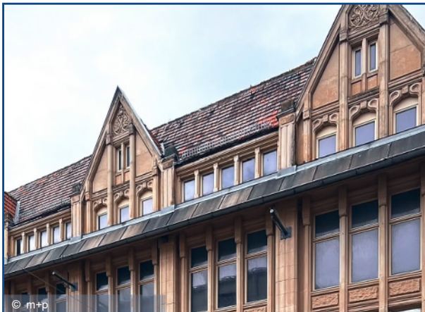
Kaufhaus, Umbau zum Hotel, Stralsund
