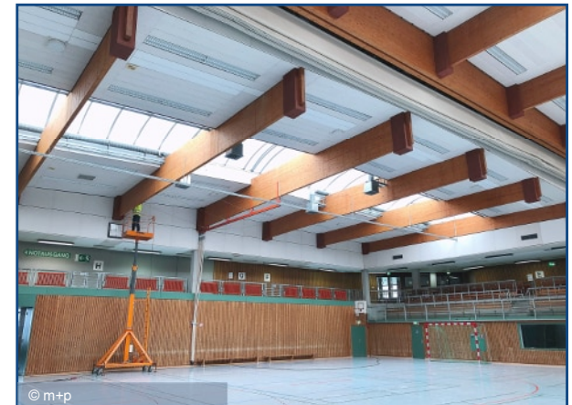
Leimbinder, Sporthalle Amselstieg, Salzgitter
