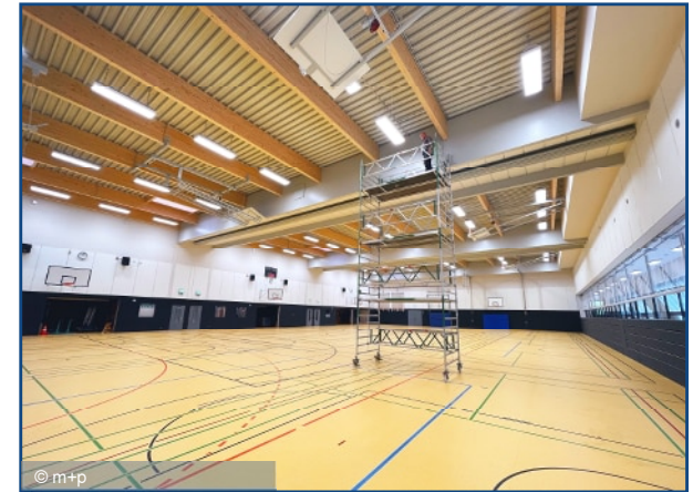
Dachbinder, Sporthalle Flutmulde, Gifhorn
