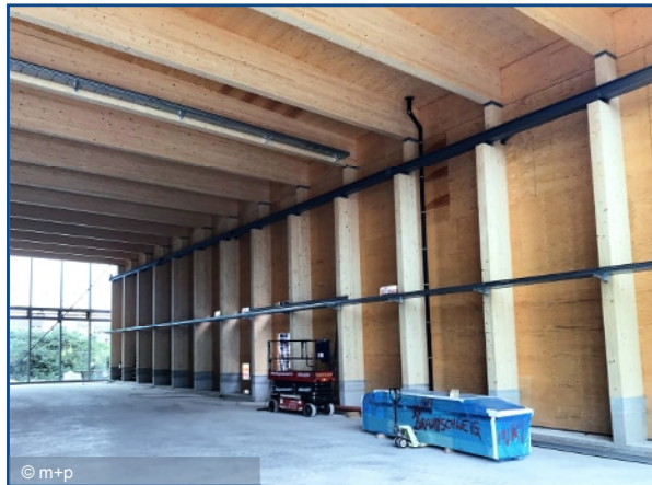
Versuchshalle, Zeluba, TU Braunschweig (stat. Prüfung)
